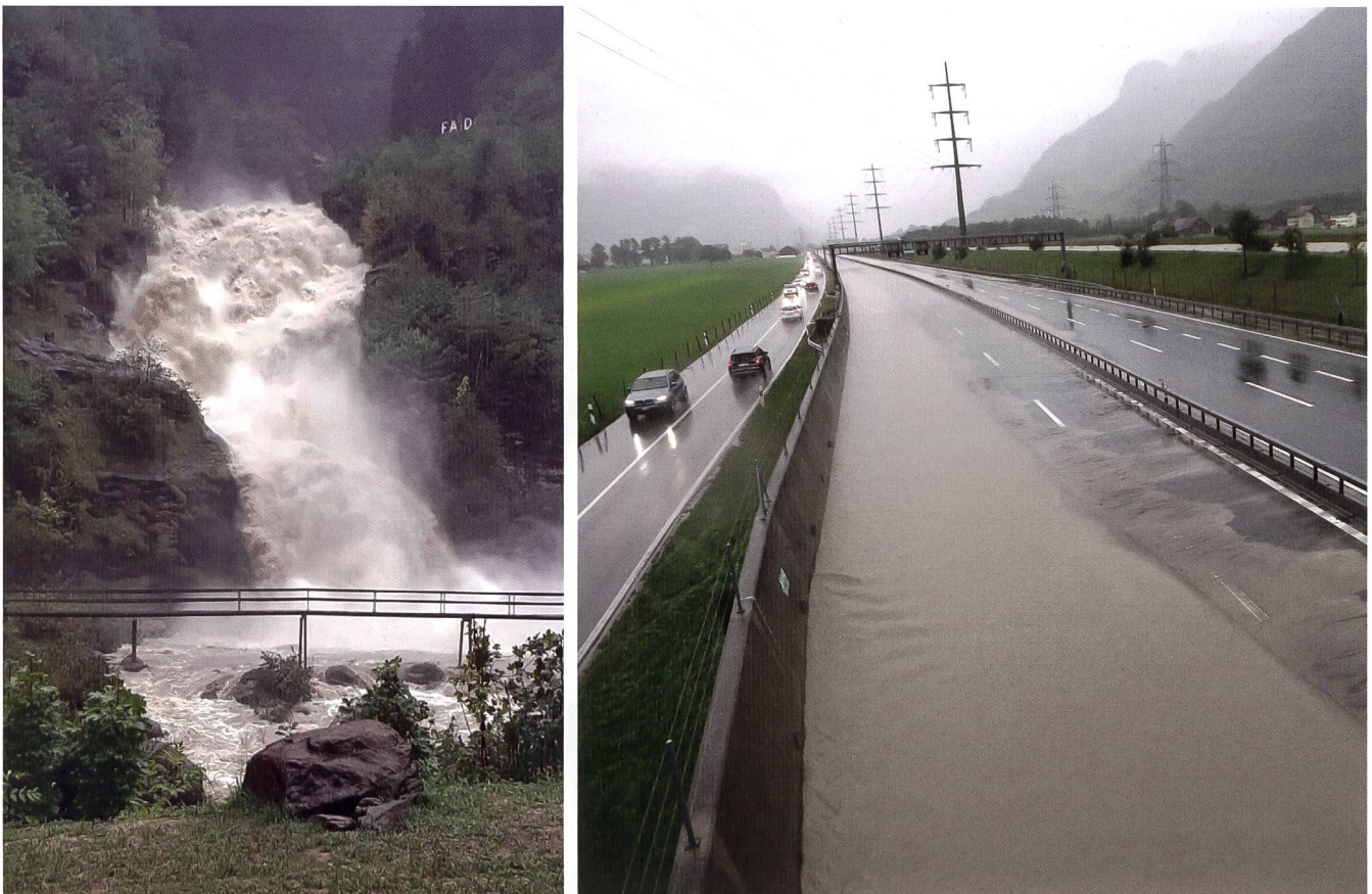
Bild 1: Links: Tosende Wassermassen am Wasserfall Piumogna (Leventina TI) nach den Regenfällen von Ende August 2020. Foto: Luca Nisi, MeteoSchweiz. Rechts: Anfang Oktober 2020 war die Autobahn A2 zwischen Beckenried NW und Erstfeld UR wegen des Hochwassers an der Reuss gesperrt. Die Überflutung der A2 fand, wie im Notfallplan vorgesehen und baulich geplant, statt. Foto: Stefan Arnold, Urner Wochenblatt.
