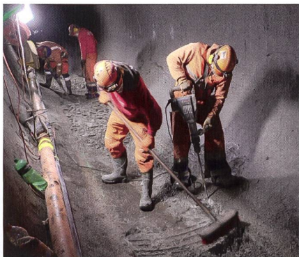
Stollensanierung im Kraftwerk Göschenen. Bild: CKW.
