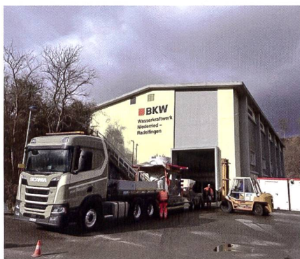
Kraftwerk Niederried-Radelfingen. Bild: BKW.
