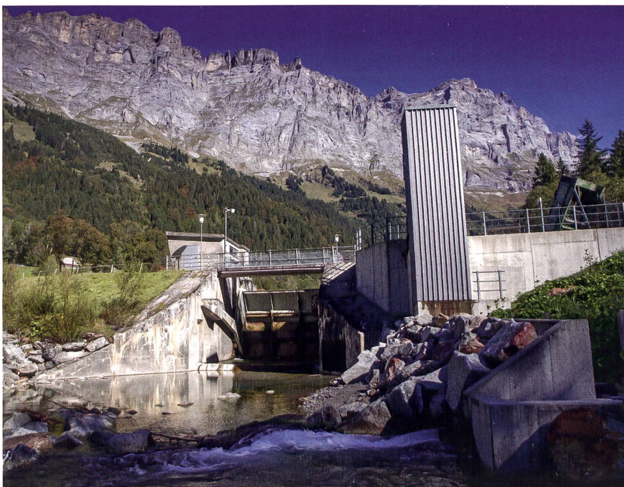
Bild 9: Fischlift im Gadmerwasser.
