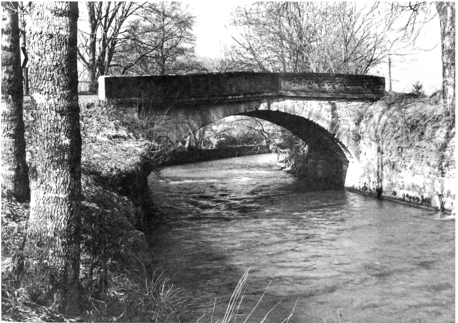
Die historische Wiggerbrücke in Altishofen: erbaut Ende der 1830er Jahre, 1854 nach Hochwasserschaden verstärkt, 1982 abgetragen
