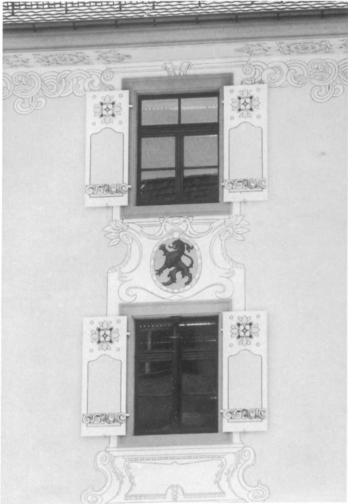
Fensterpartie an der Hauptgasse.
