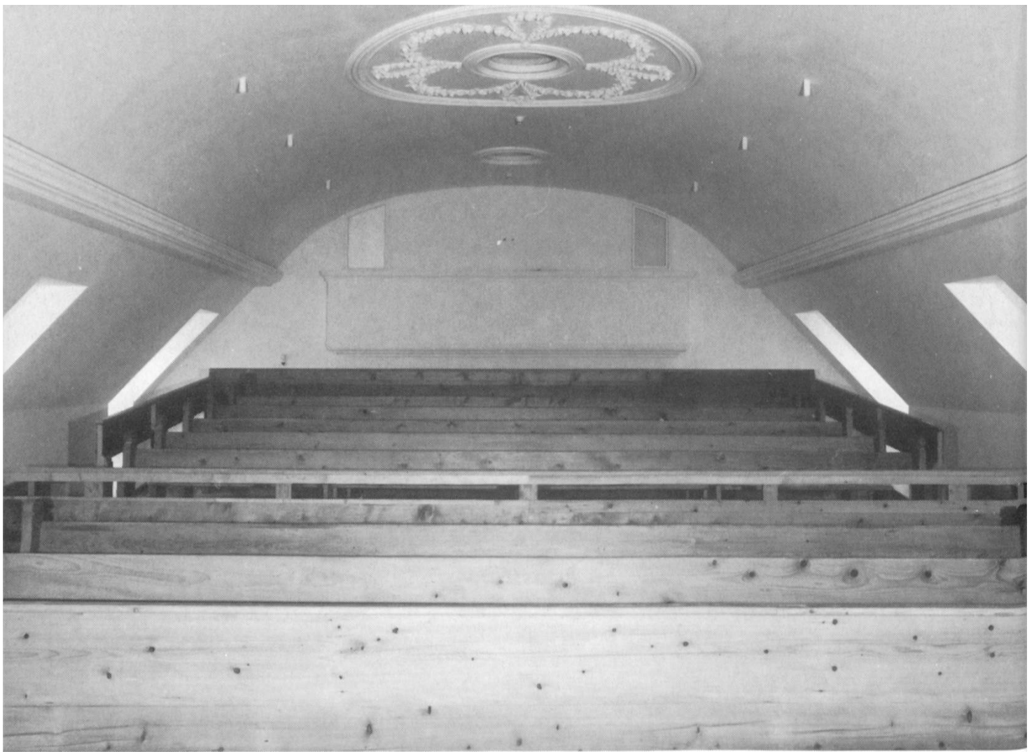
Das in den Dachstock verlegte, aus dem frühen 18. Jahrhundert stammende spätbarocke Innentheater.
