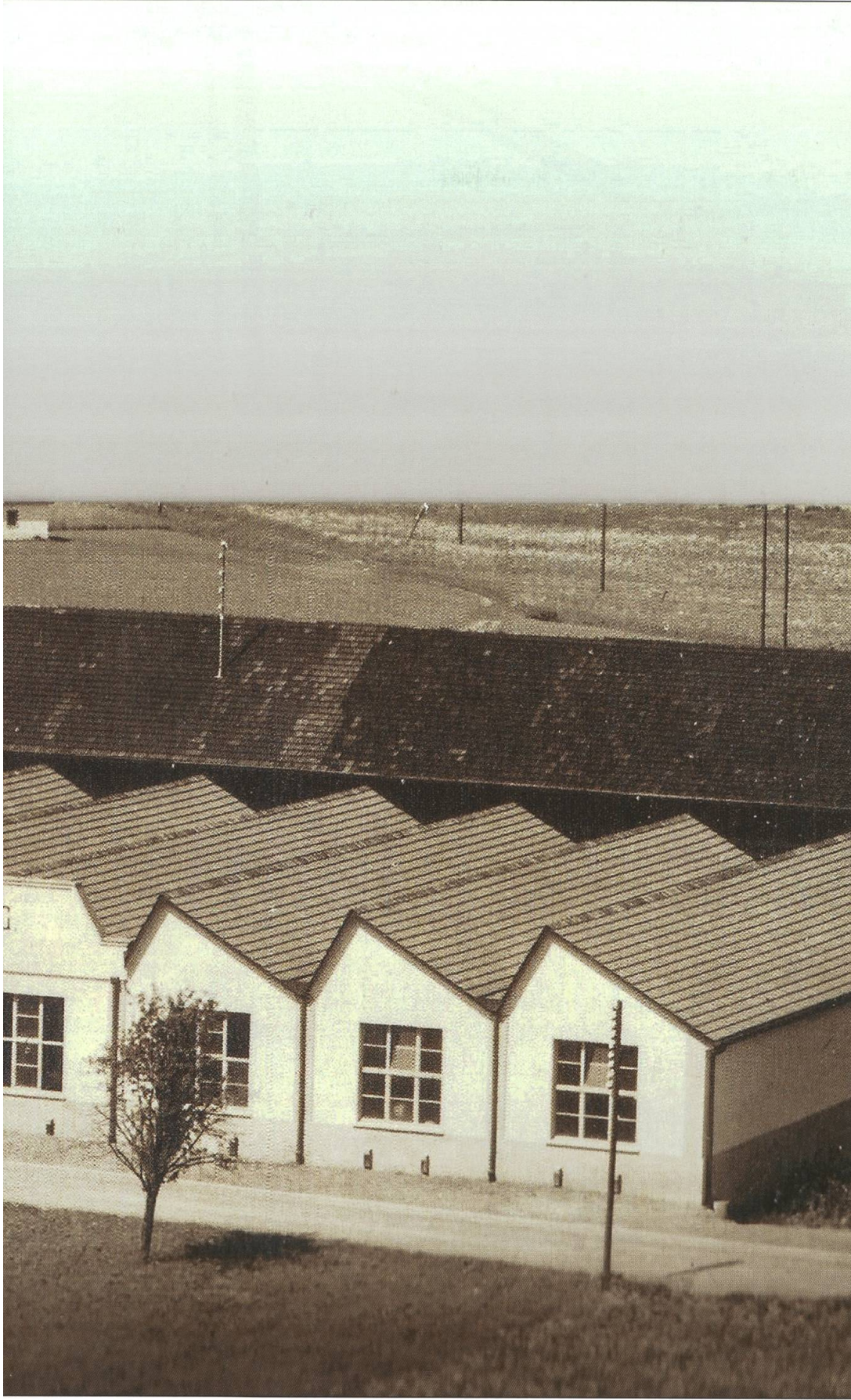
Abbildung 1. Die Südfassade der 1929 errichteten Möbelfabrik Willisau AG, die die sägezahnförmigen Elemente des Sheddachs in die Gestaltung aufnimmt. Fotograf unbekannt
