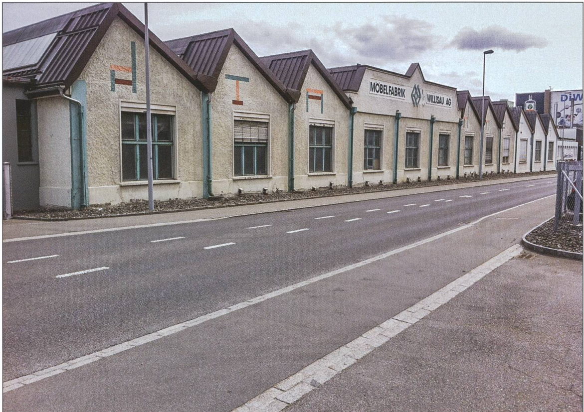
Abbildung 4. Die 1962/63 durch drei Achsen erweiterte Südfassade in ihrem heutigen Zustand. Foto Cäsar Menz
