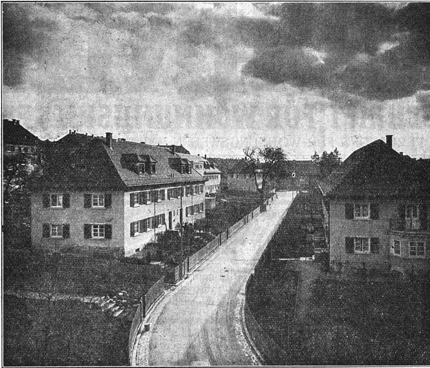
Wohnkolonie der Baugenossenschaft Vrenelisgärtli Zürich im „Eisernen Zeit“ vom Jahre 1927, mit elektr. Küche.
