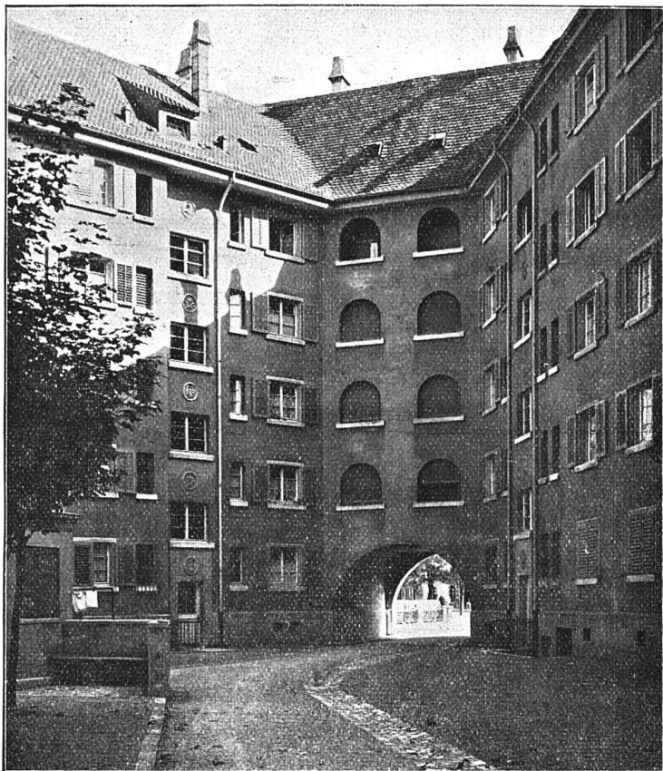
Hofansicht aus der Wohnkolonie an der Josef-Röntgen-Albertstrasse der Baugenossenschaft des eidgen. Personals Zürich
