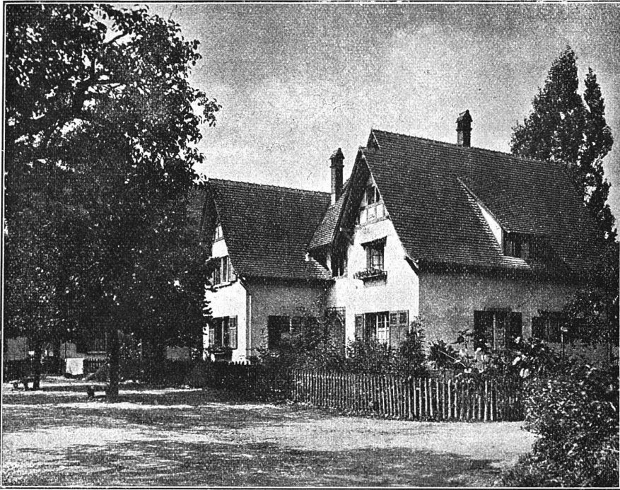
Wohnkolonie „Schwarzadlergütli“ der A.-G. der Eisen- u. Stahlwerke Schaffhausen
