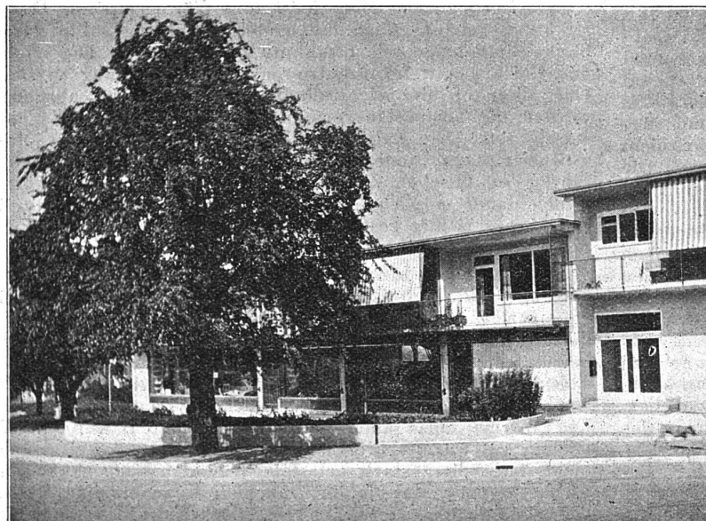
Reihe 1. Das nördliche Ende der Siedlung (Einzimmerwohnungen, Läden)
