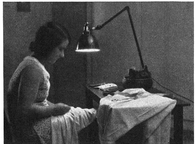
Einwandfreie Lampe am Arbeitsplatz. Der Reflektor schirmt die Glühlampe gut ab. Die vielseitige Verstellbarkeit ermöglicht weitgehende Anpassung
