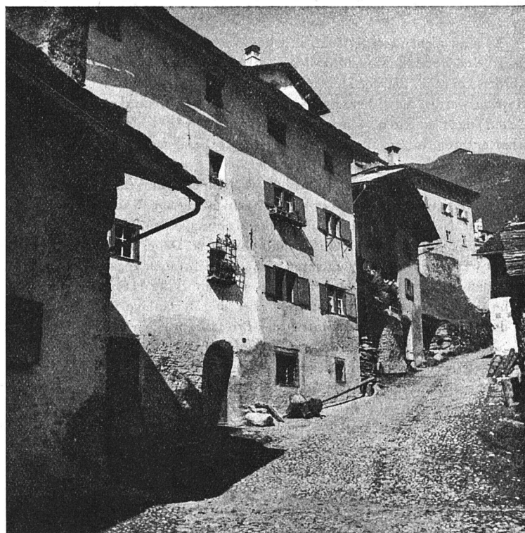
Splügen. Gasse mit Steinhäusern «an der Sust».
