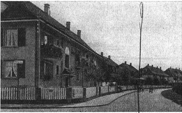
Gemeinnützige Bau- und Wohngenossenschaft „Freistatt“, Thun Bestehende Anlage
