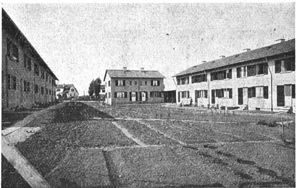
Ansicht der Höfe, zwischen den Häuserzeilen
