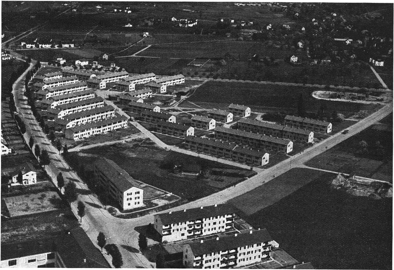
«ASIG», Baugenossenschaft, Zürich 11
