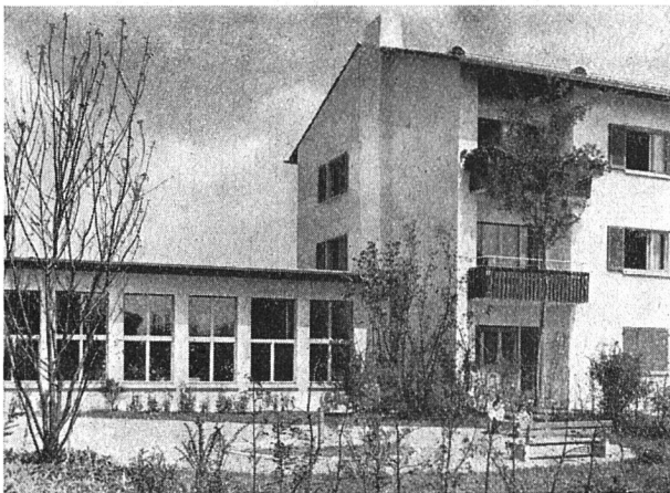
Kindergarten mit Mehrfamilienhaus an der Nordheimstraße
