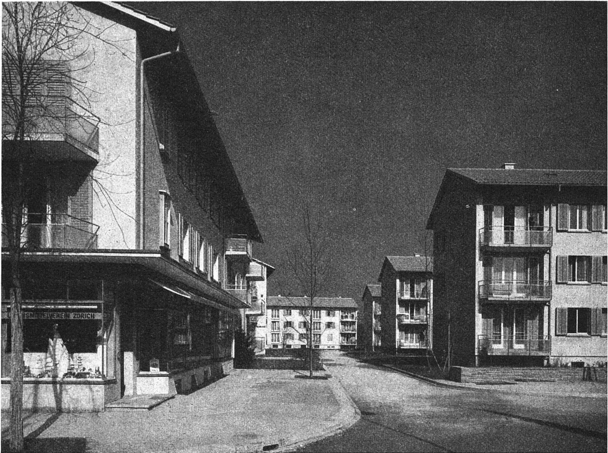
Siedlung «Im Herrlig» der Allgemeinen Baugenossenschaft, Zürich
