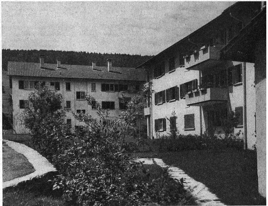
Mehrfamilienhäuser der Mietergenossenschaft «Alpenblick», Horgen
