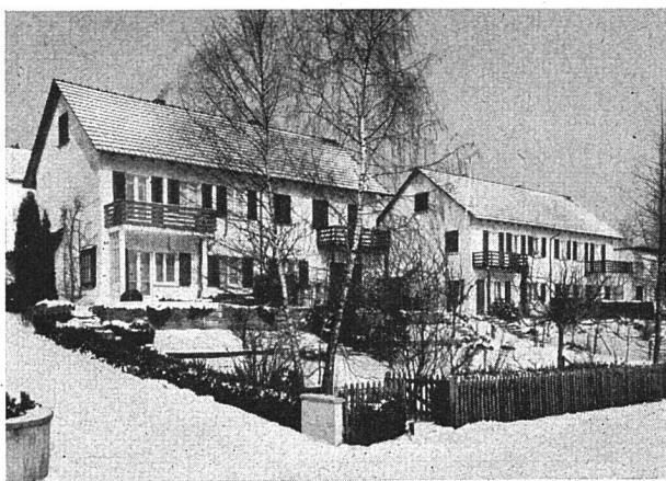
Wohnbaugenossenschaft Olten und Umgebung, Gallusstraße
