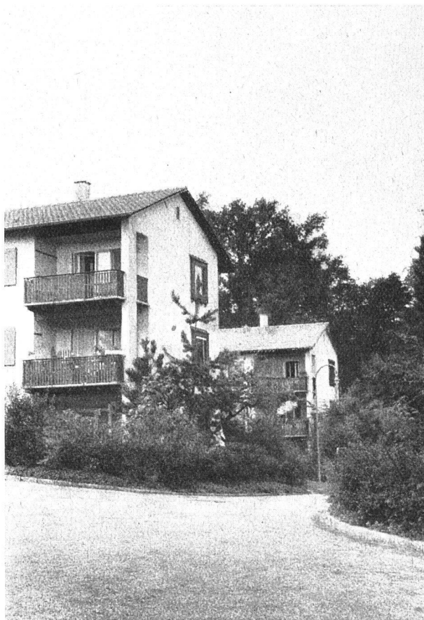
Mehrfamilienhäuser am Jakobsberg
