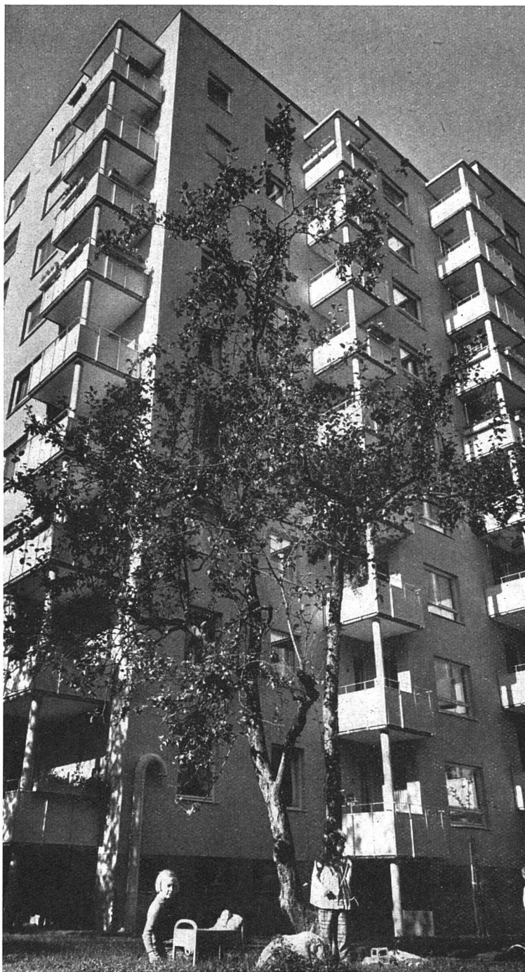
Der Balkon ist ein nötiger Bestandteil jedes schwedischen Mehrfamilienhauses. Er drückt den Fassaden seinen Stempel auf.
