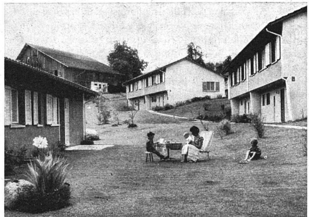
Fig. 2 Einfamilienhäuser der Baugenossenschaft «Krummbächli», Richterswil
