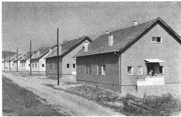
Ganze Straßen mit Typenhäusern werden serienweise auf einmal gebaut Architekt: Ing. K. Vitanović, Zagreb
