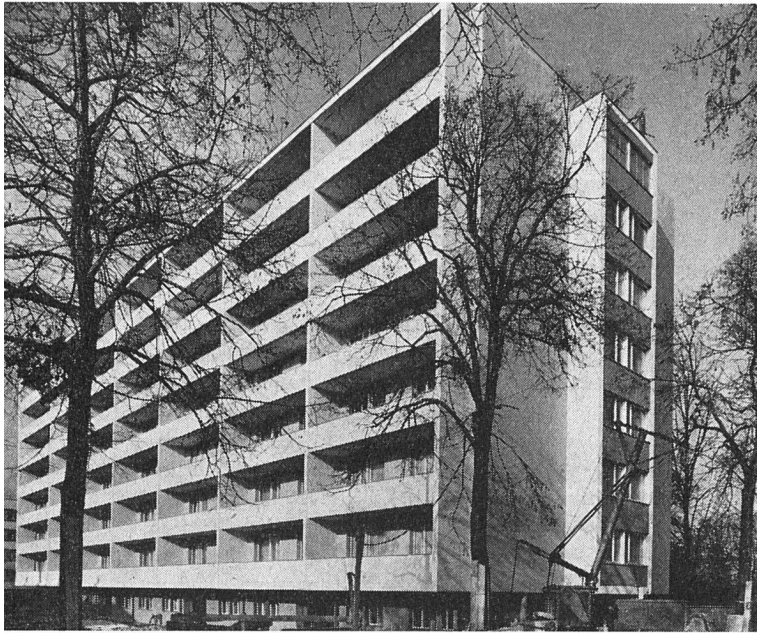
BBB Lindenhofstraße, Südseite — Photo: A. Löhndorf, Basel
