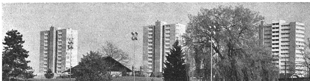
Drei Wohnhochhäuser der Siedlung Außerholligen in Bern
