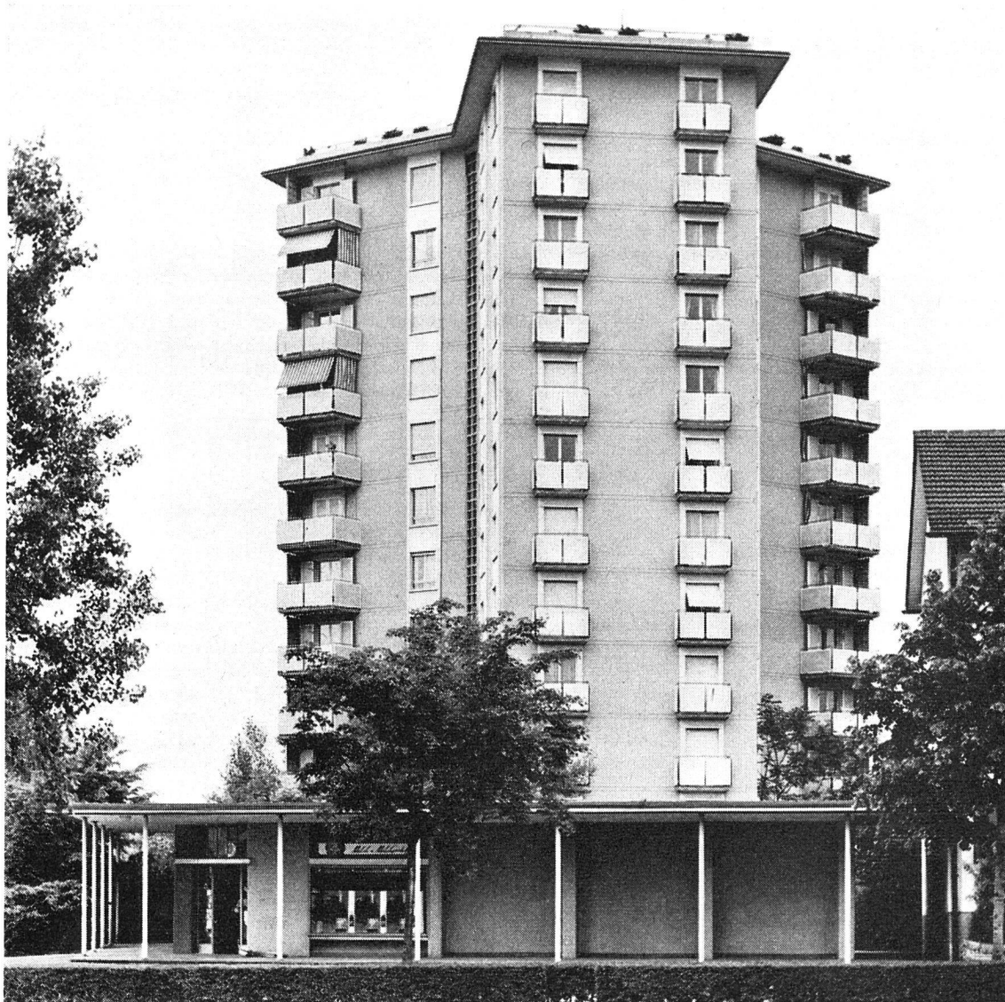
Hochhaus «Im Gut»
