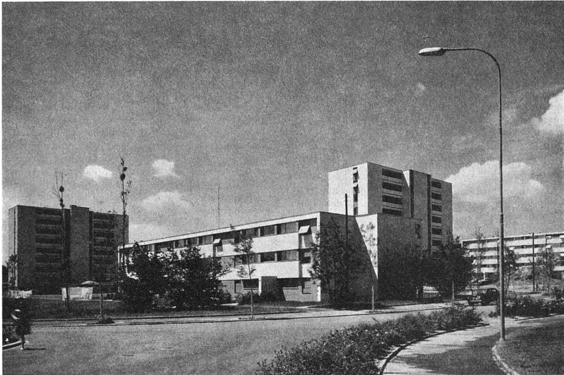
Die beiden Hochhäuser, links das der ASIG, rechts das der ROTACH
