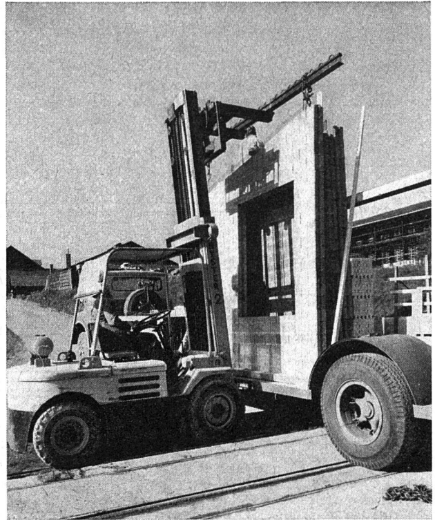
Verlad von Mauertafeln in der Ziegelei
