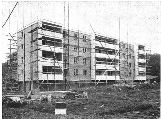
In St. Gallen wurden die Bauten der Baugenossenschaft VHTL unter Verwendung von vorfabrizierten Elementen erstellt
