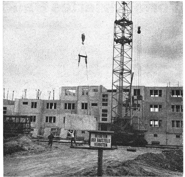
Montage von vorgefertigten Bauelementen in Wien
