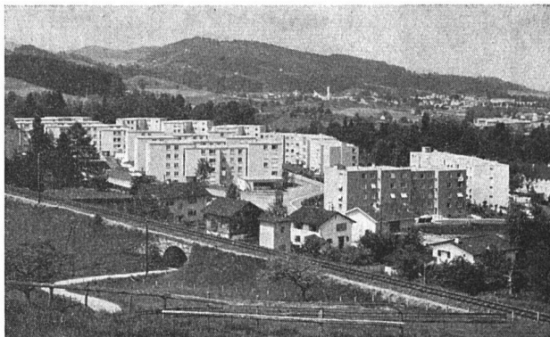
Wohnsiedlung mit Hälg-Deckenstrahlungsheizung
