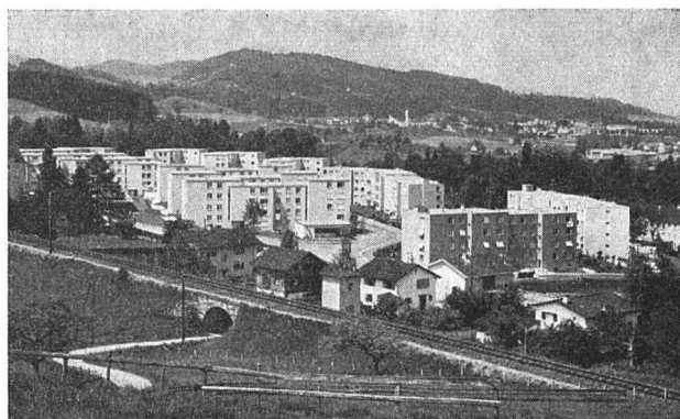
Wohnsiedlung mit Hälg-Deckenstrahlungsheizung
