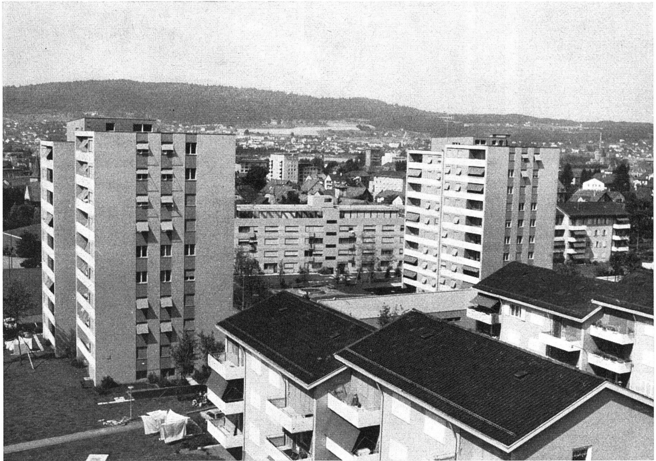
Die beiden Hochhäuser von Süden; links = freier Wohnungsbau, rechts = allgemeiner Wohnungsbau (zwischen den beiden Hochhäusern die Alterssiedlung, erstellt durch die Gemeinde Schlieren).
