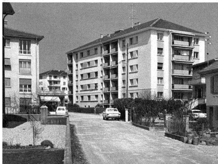
Société coopérative Cité des Philosophes, chemin Buvelot, 1965, 32 logements. Architecte Ch.-P. Serex.
