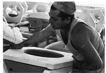
Aufsetzen der Abdeckplatten
