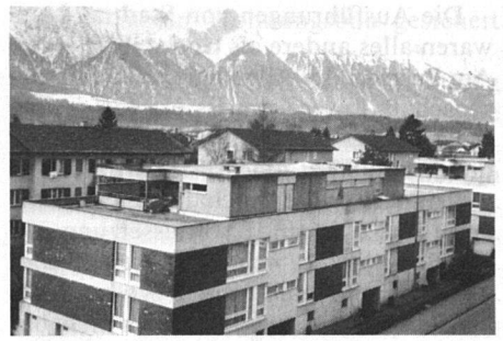
Sanierte Flachdächer an der Hallerstrasse in Thun.
