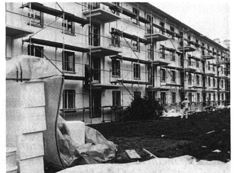
Teil der totalen Gebäudeisolierung: Fassadenisolation.
