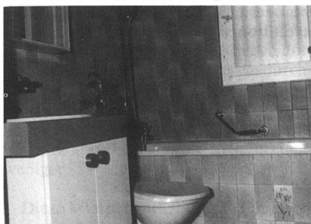
... werden neu gestaltet.
