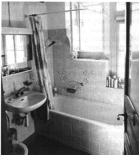
Neu installiertes Bad/WC (Photos: J. Vitelli)
