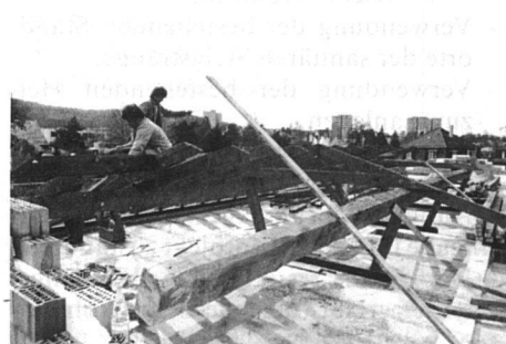
Isoliertes Geschoss, während der Demon- tagage des Dachstockes
