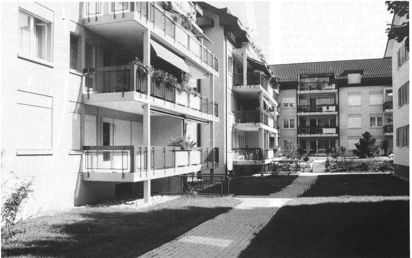
Im Hofraum der Siedlung kann man die extreme Lage längs einer sechsspurigen Autobahn fast vergessen. (Foto: Karin R. Lischner)
