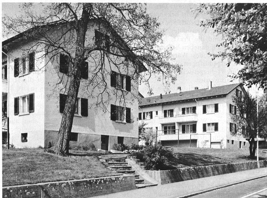
Baugenossenschaft Fröhlisberg in Biel: Siedlungsausschnitt
