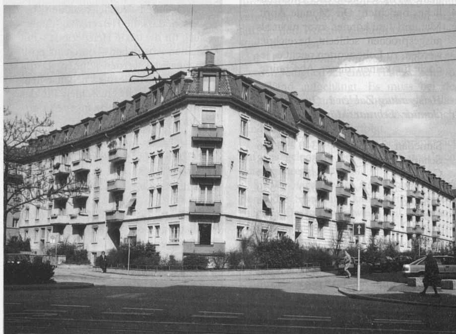
Die 210 Wohnungen der Dr.-à-Porta-Stiftung an der Hegarstrasse in Zürich haben die sauberste Heizung weit und breit.
