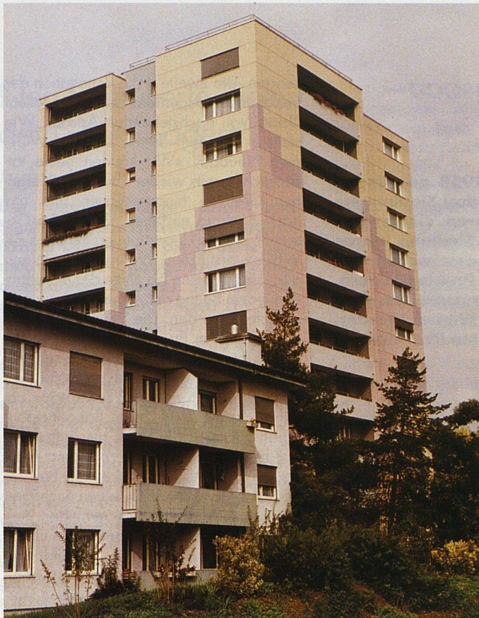
Text: Rudolf Baumann Foto: Baumann & Waser, Architekten, Lenzburg
