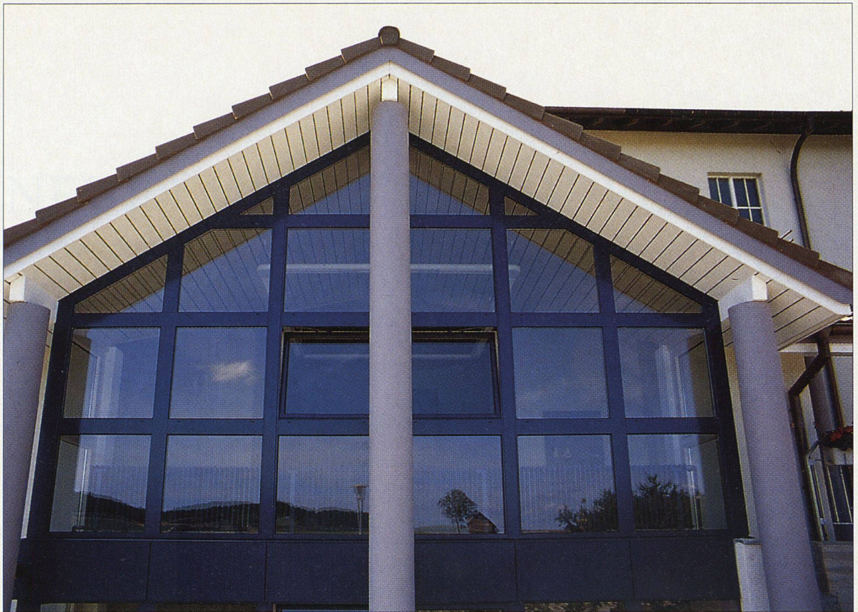
Eine Hausfront aus Glas: Elegant in der Wirkung, hell als Arbeitsplatz – die Reinigung jedoch dürfte schwierig sein.
