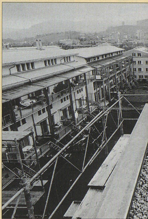
Blick nach Süden über den Innenhof. Links die Bauteile der Genossenschaft «G 91», rechts von «Remishueb»
