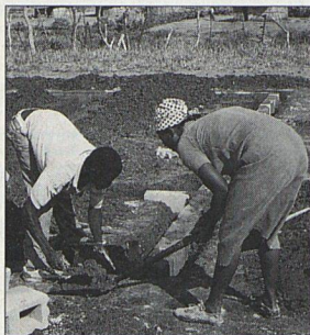
Massaca I in Moçambique ist eines von mehreren SVW-Wohnbauprojekten.
