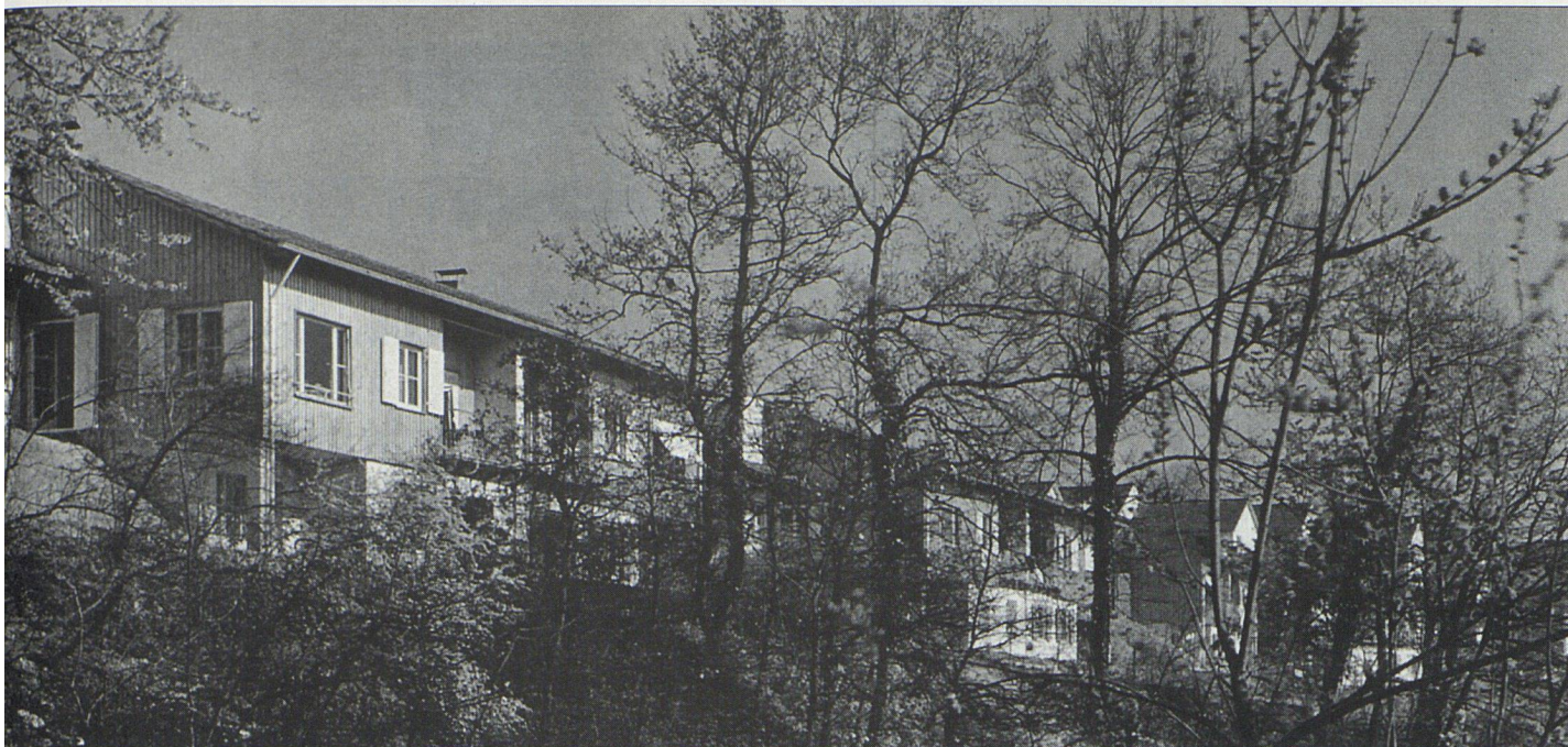
Siedlung Jakobsberg Basel, erste Etappe: Hermann Baur versuchte, die gewachsene topografische Struktur zu erhalten.
