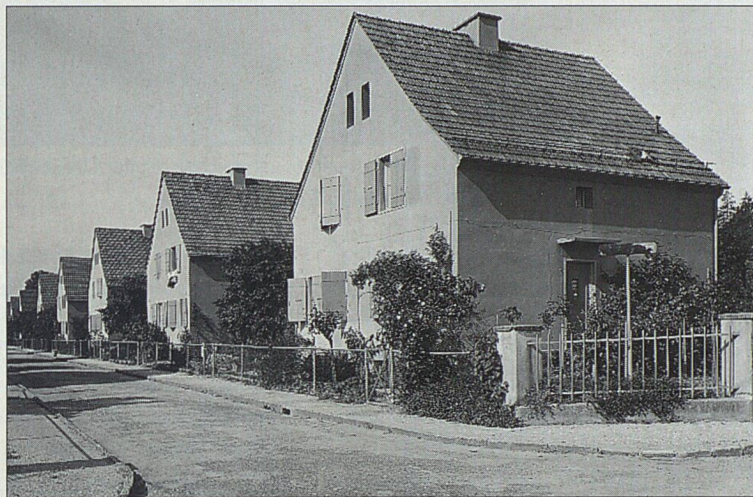
Die Gartenstadt – weit ausserhalb von Genf gelegen – entsprach den damaligen baulichen und gesundheitlichen Idealvorstellungen der SCHG-Gründer.
