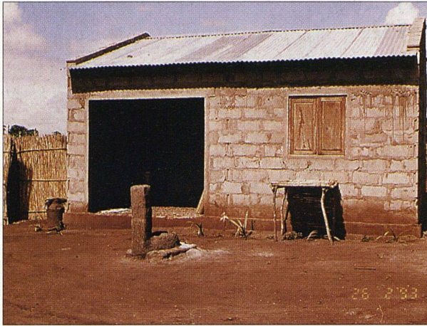
In Moçambique ist etwa die Hälfte der Arbeiten abgeschlossen. Der Bau der Häuser orientiert sich an der traditionellen Lebensweise, die Feuerstelle befindet sich ausserhalb des Hauses.
