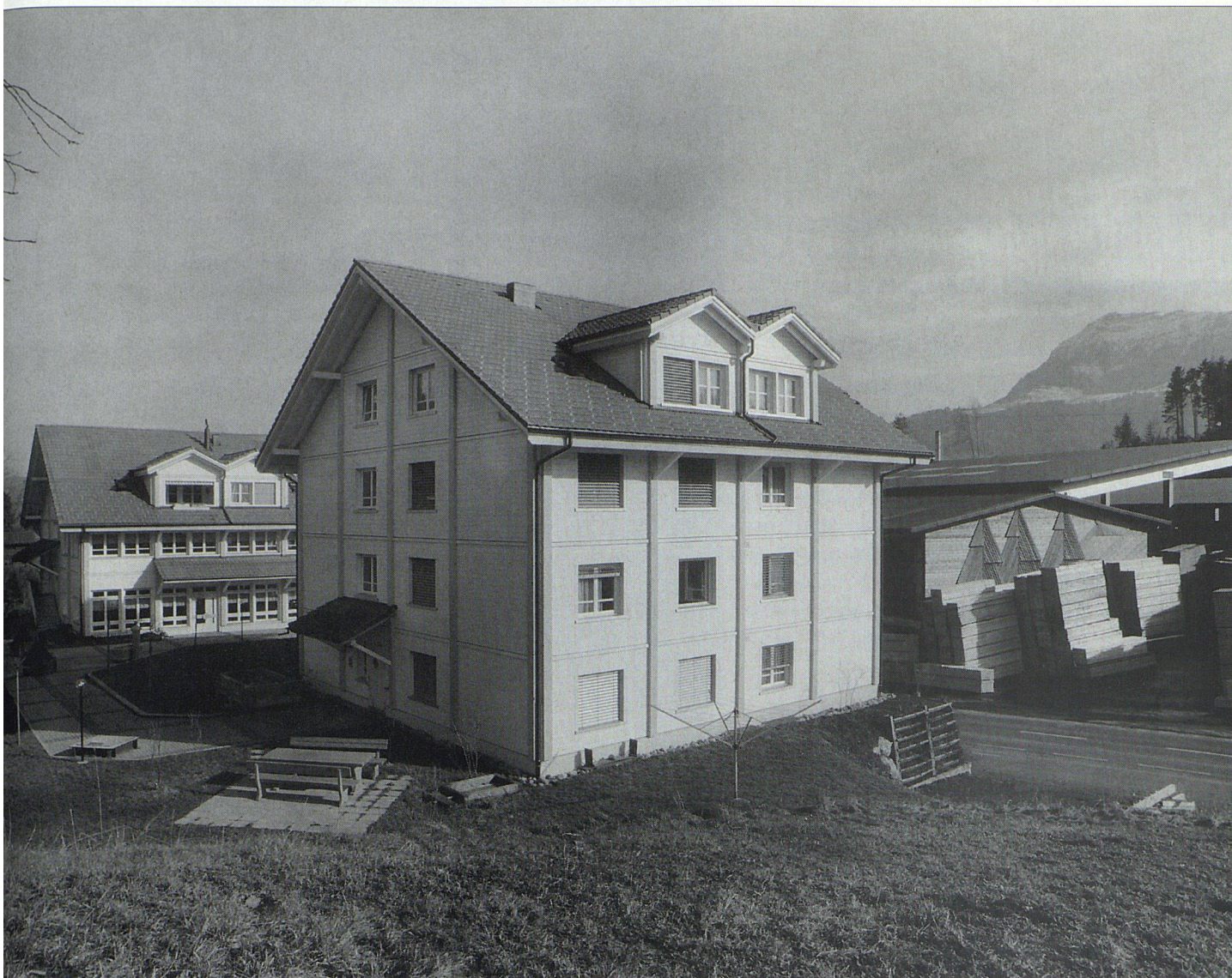
Preisgünstige Holzhäuser in Küssnacht am Rigi. Wer ein solches Haus erstellen will, braucht wegen aufwendiger Brandschutzkonzeptes sehr viel Geduld.
