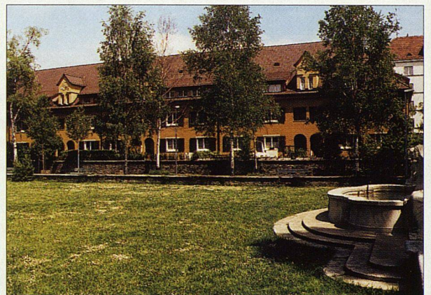
Der Birkenhof, Zürich-Milchbuck: überblickbar und deshalb sicher.
