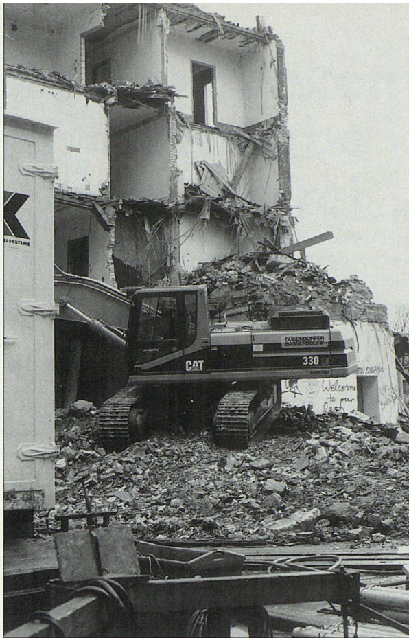
Abbruch mit der schweren Eisenkugel gibt's nicht mehr. Alles Brauchbare wurde vorher sorgfältig demontiert.
