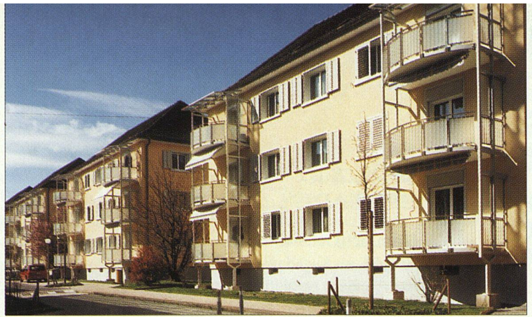
Die Eisenbahner-Baugenossenschaft Zürich-Altstetten hat ihre Siedlung mit einem umfassenden Erneuerungskonzept für die Zukunft gerüstet. Die neuen Balkone tragen zu einem erweiterten Wohnwert bei.
